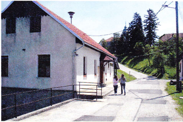
Vatrogasni dom u Poljani Sutlanskoj U obje ove zgrade nastave nema od 1. rujna 1974. g. jer ih je tada potres onesposobio za daljnji rad u njima. Sada su renovirane.
